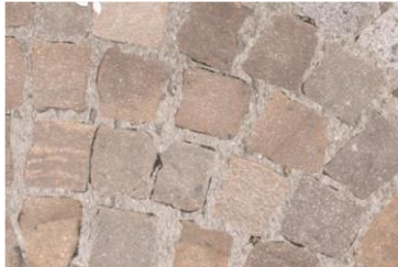
Natursteinpflaster in Beton
